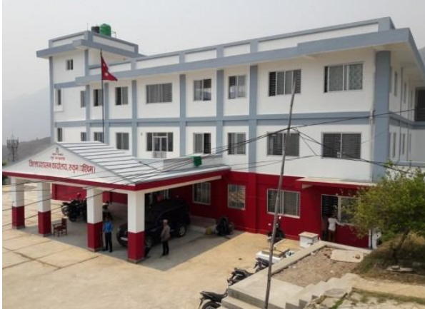
जिल्ला प्रशासन कार्यालय रुकुम (पश्चिम)को भवन
